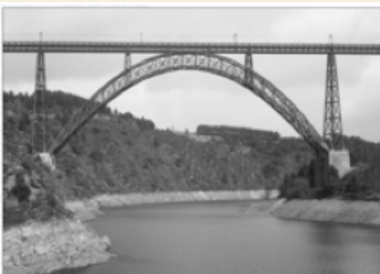
Viaduc de Garabit
